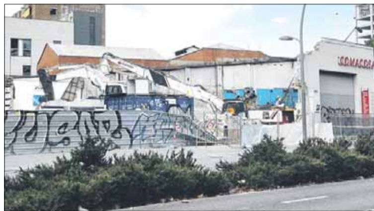
Les màquines ja treballen en l'enderroc de la zona afectada
