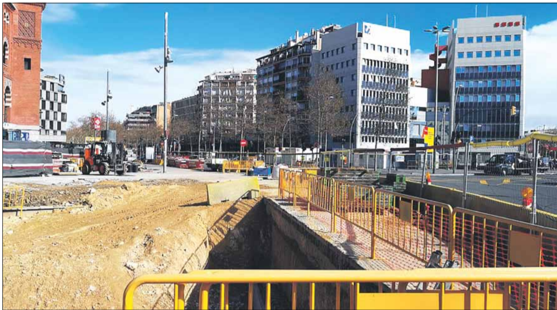
Les escales en construcció que donaran accés a l'L1 i l'L3 a la plaça Espanya
