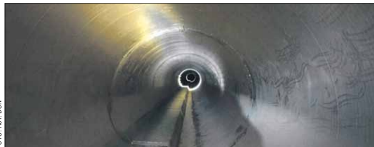
Imatge de l'interior del col·lector ja executat
