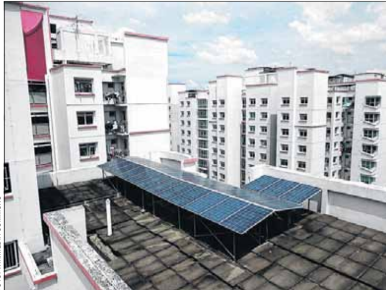
Exemple de plaques solars en una coberta d'edifici
