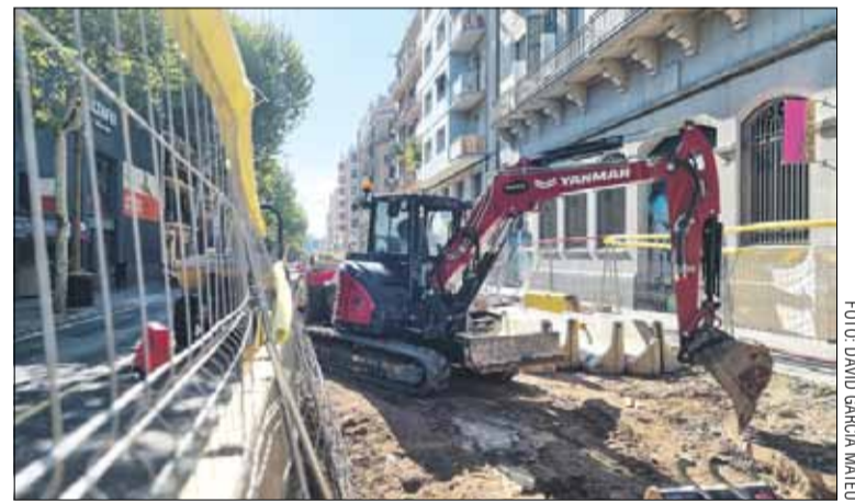
Des de fa setmanes les retroexcavadores treballen a la zona
