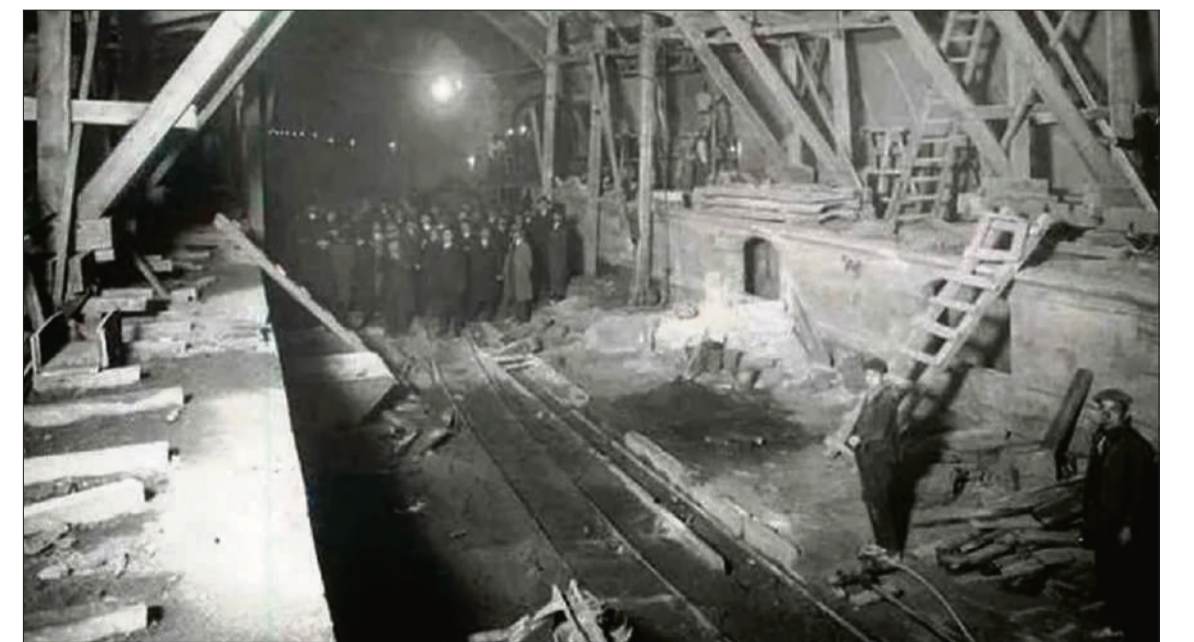
L'interior del túnel on va haver l'accident d'abril de 1924
