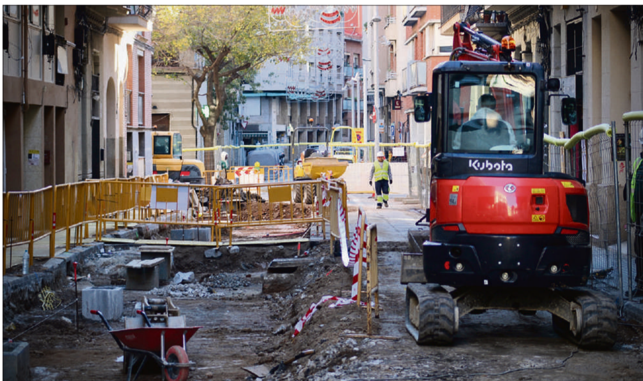
Les obres deixen un petit pas per a vianants a banda i banda del carrer
