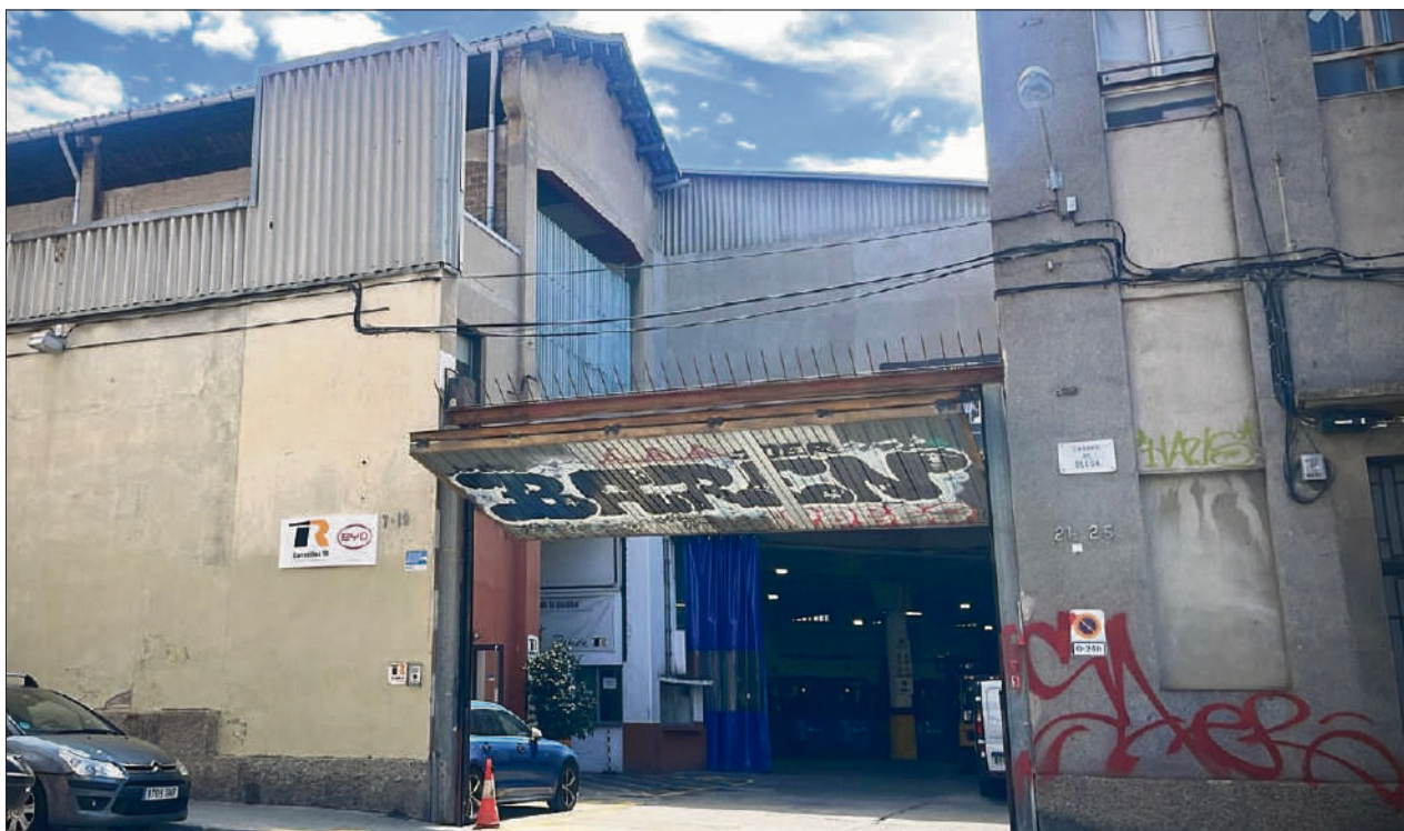
L'Ajuntament fa la primera passa per expropiar Blesa 7-29 i convertir la finca en un equipament municipal
