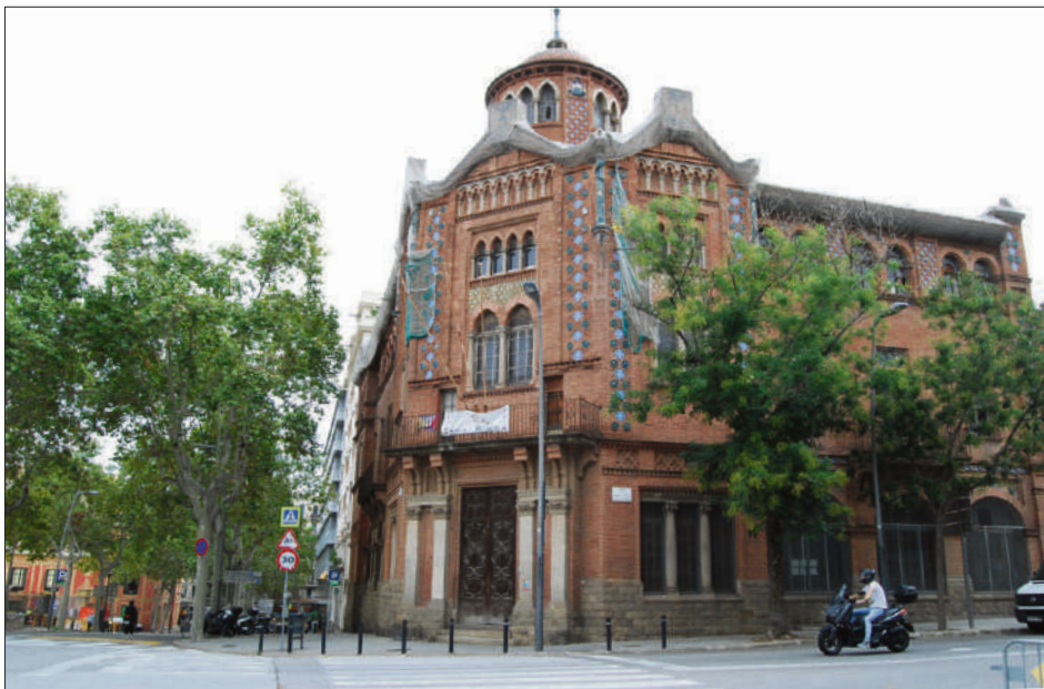
Estat actual de la façana de la Casa de la Premsa
